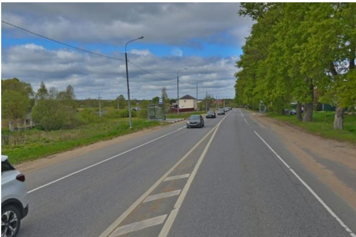
Рисунок 2.1.6.1 – Отсутствие пешеходного перехода на ОП "Крутицы" на автомобильной дороге Можайское шоссе
